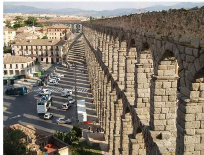
Aqueduto de Segóvia (Espanha) – 15 km extensão Século I-II d.C.
