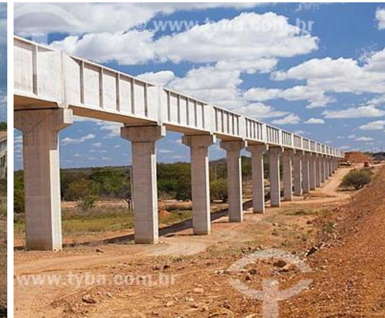
Canal prismático – seção transversal igual em toda a extensão do canal.
