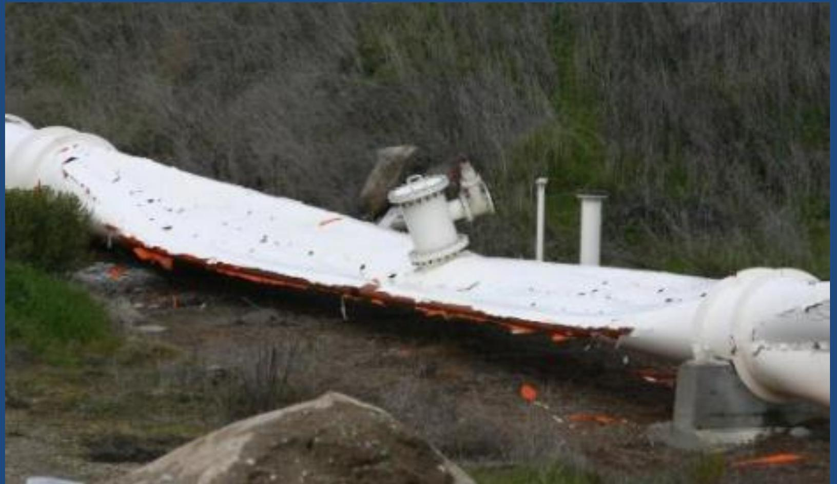
Na Califórnia adutora com 1,00 m de diâmetro colapsa.
