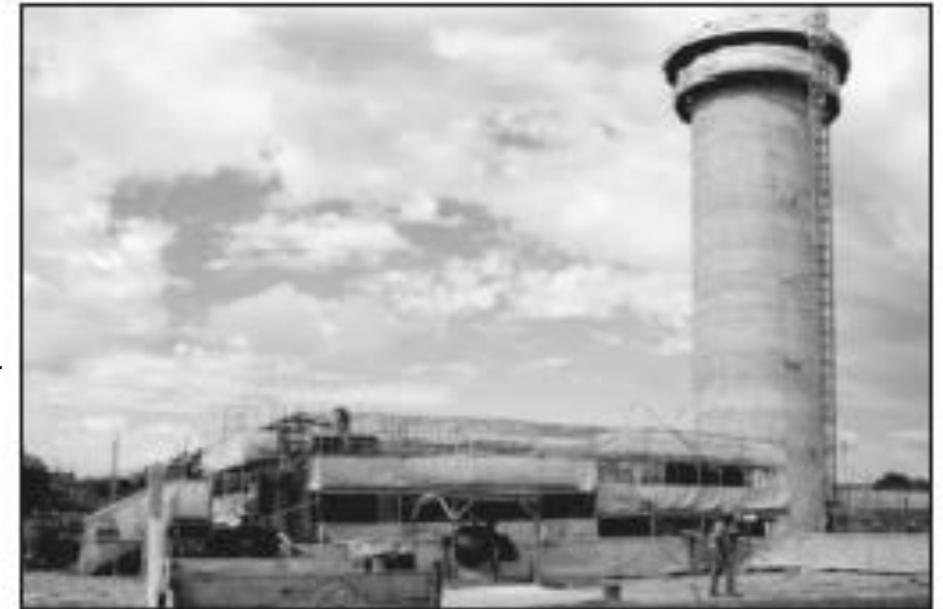
Figura A-12.7.3.2-b – Chaminé de equilíbrio – equipamento das obras do Departamento Municipal de Águas e Esgotos (DMAE), Porto Alegre, RS.
